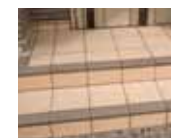
垂付段鼻と平部分の色を変えると段差の視認性がよくなります。
