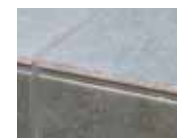
施釉品での平のみの納まりは小口に素地の色が見えます。
