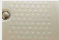
浴槽内の滑り止め
