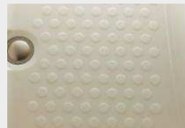
浴槽内の滑り止め
